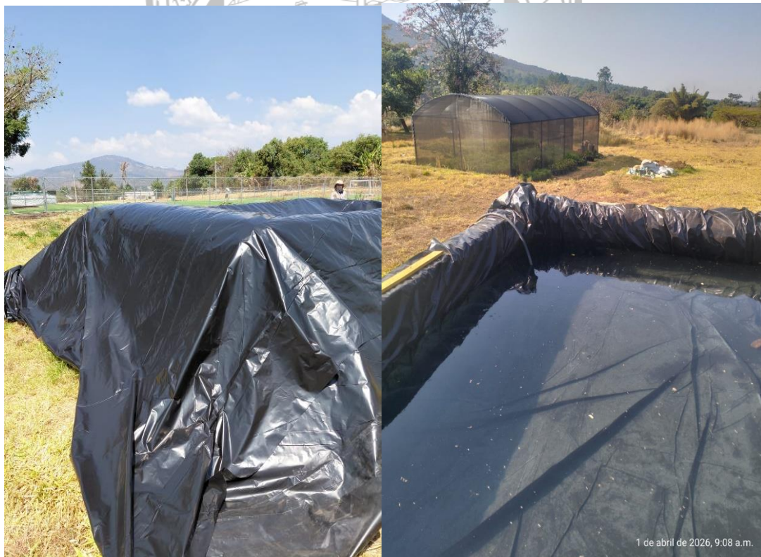
Figura 9. Rehabilitación de la olla de captación de agua en la unidad deportiva.
